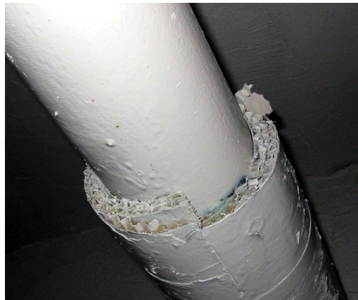
Tuyaux isolés à l'amiante.
