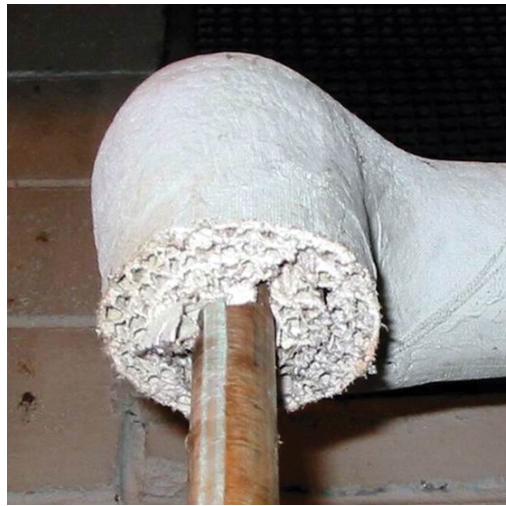
Tuyaux isolés à l'amiante.
